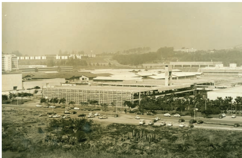
Figura 4 – Vista aérea dos edifícios dos Departamentos de Engenharia Mecânica e Naval da Escola Politécnica (EP-USP). (Fonte: Arquivo da SEF-USP)
