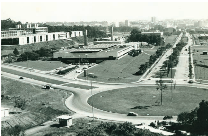
Figura 3 – Vista aérea da obra entregue do edifício de História e Geografia da Faculdade de Filosofia, Letras e Ciências Humanas (FFLCH-USP). (Fonte: Arquivo da SEF-USP)
