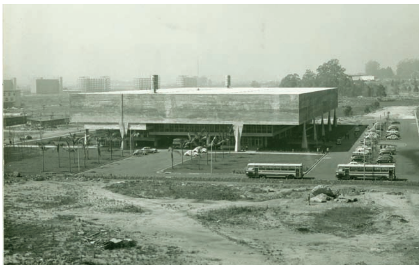
Figura 2 – Etapa final da construção do icônico edifício da Faculdade de Arquitetura e Urbanismo (FAU-USP). (Fonte: Arquivo da SEF-USP)
